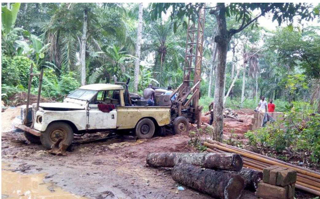
Die Bohrung ist in 200m Tiefe auf eine Wasserader gestoßen.
